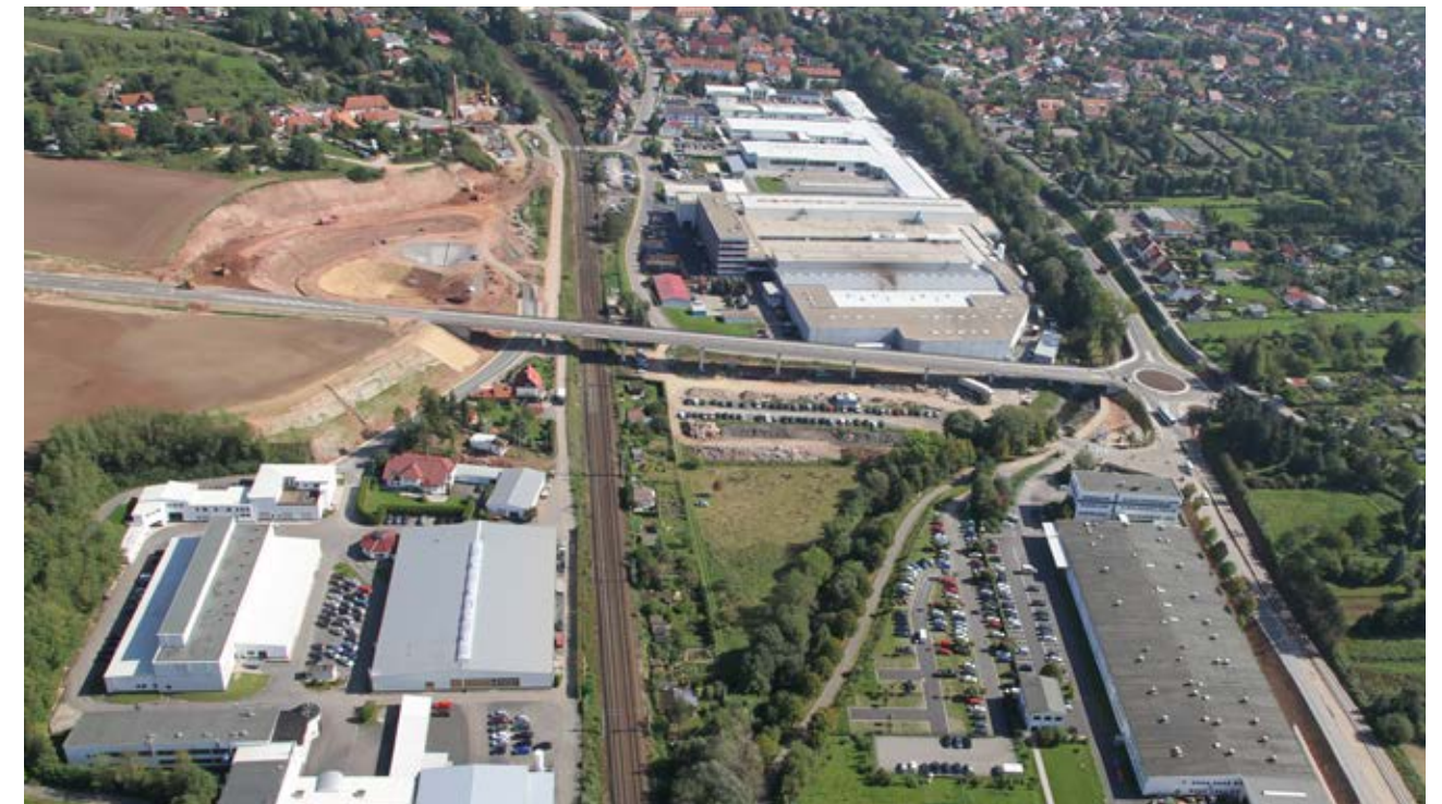
Talbrücke über die Leine
