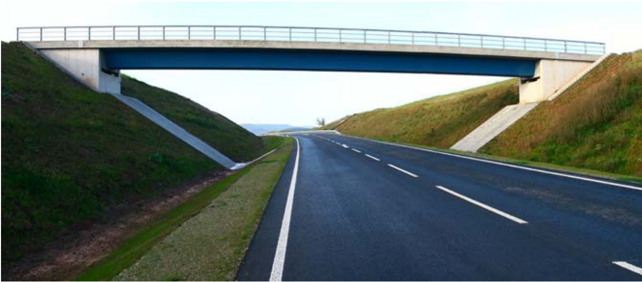
Brückenbauwerk 2, Blickrichtung Süd
