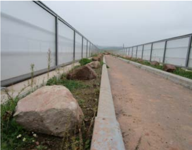
Brückenüberbau Bauwerk 2 mit Amphibienlauffläche
