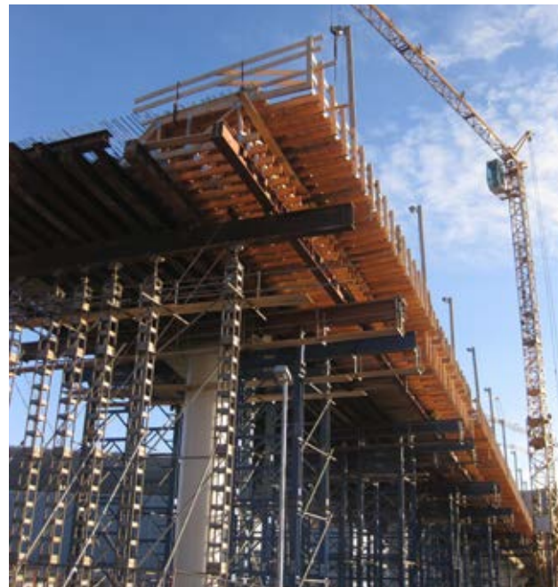
Montage des Traggerüsts
