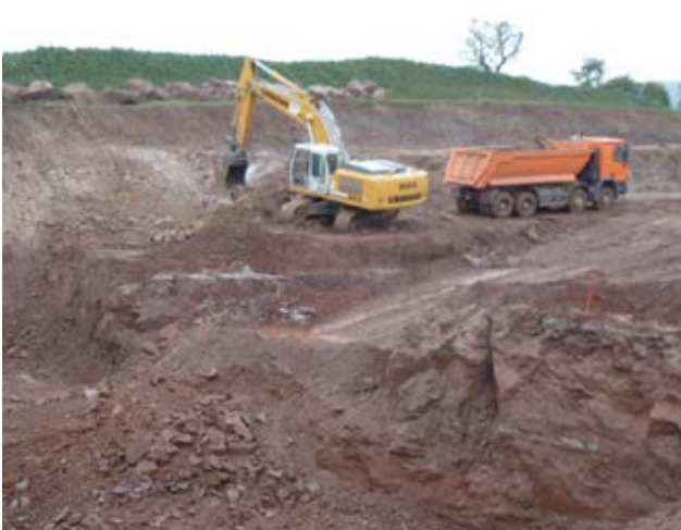
Abgrabung von Fels nach Lockerungssprengung am Bauwerk 2
