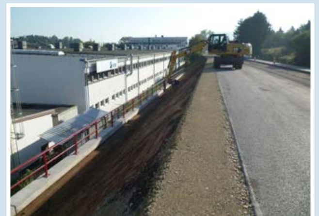
Stützwände an der L3080
